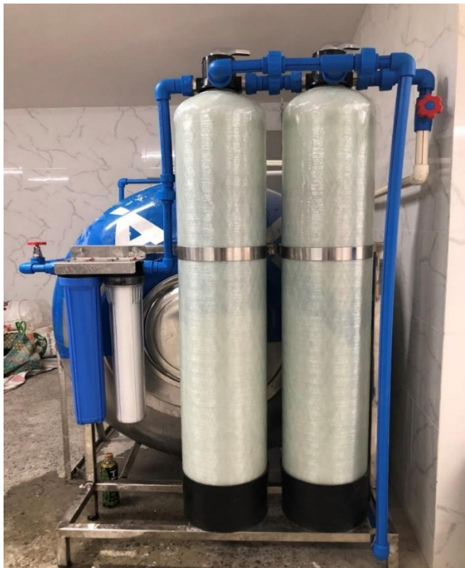
Hệ thống lọc nước cấp
